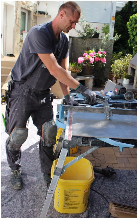
Foto: Fliesenlegerhelfer Vasyi Prokopovych auf der Baustelle.
